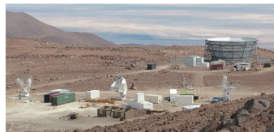
図 2: チリアタカマ高地に建設中の Simons Array 望遠鏡群 (手前)。
