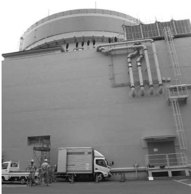
図 2.3.2: トラックに積載した状態で関西電力大飯発電所に設置された PANDA36
