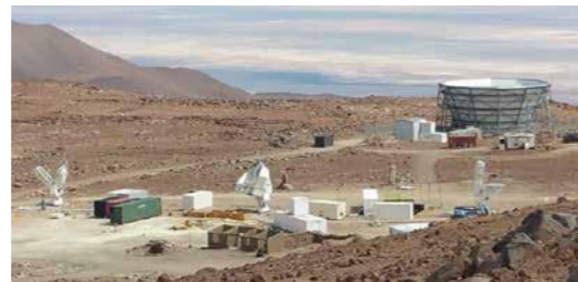
図2：チリアタカマ高地に建設中の Simons Array 望遠鏡群(手前)。
