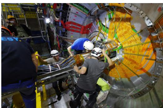
図 2.2.2: 崩壊点検出器の Belle II 検出器へのインストール。
