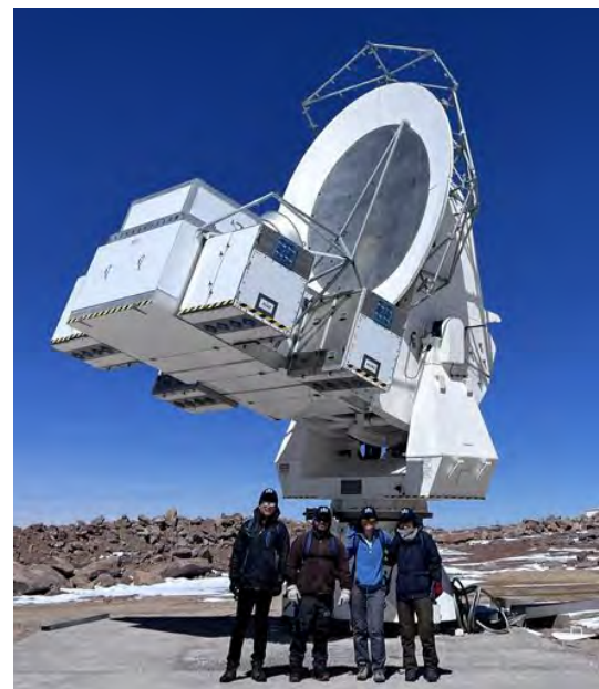
図 6.6.12: チリ観測所での Simons Array 2 台目望遠鏡建設作業の様子。検出機較正装置などの導入を完了させ物理観測を開始させた。
