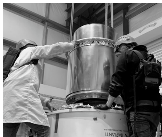
図 6.5.15: チリ観測所での光学筒インストール作業の様子。
